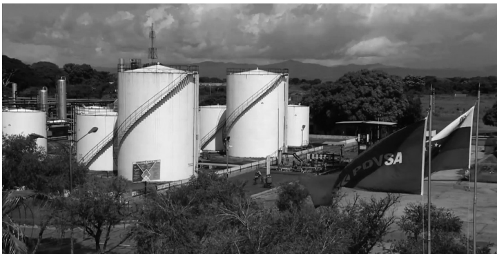
Instalaciones de Pdvsa-Vassa
