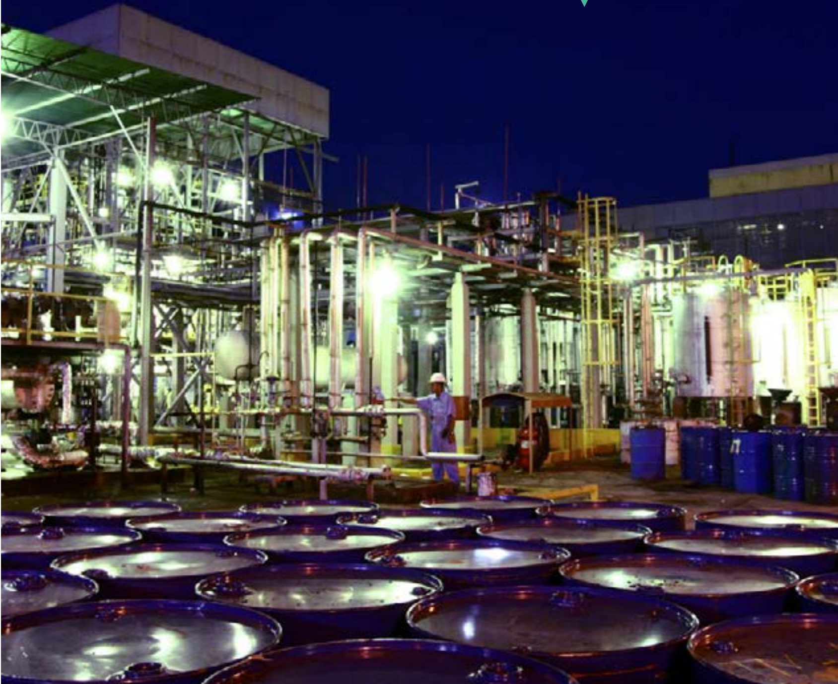
Vista nocturna Planta Piloto, Intevep Los Teques..
